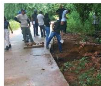
c) Descalçamento severo de passeio
