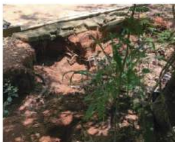
b) Cicatriz de erosão pela ausência de elementos de microdrenagem
